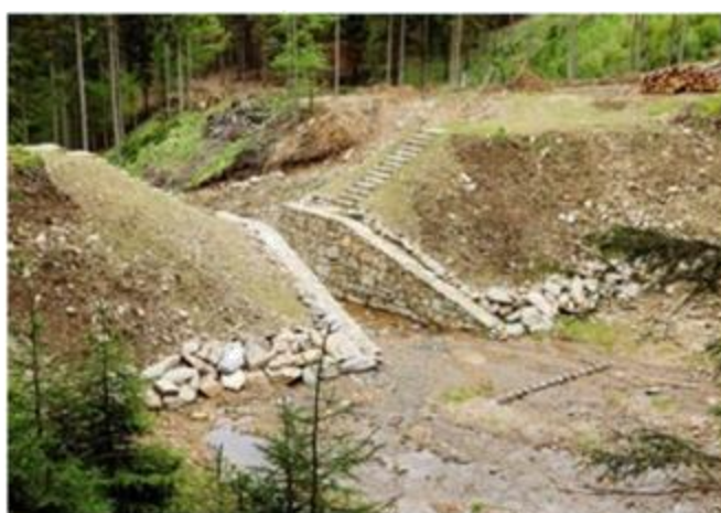
Widok na zaporę czołową dawnego zbiornika na cieku do spławu drewna przerobionego na zbiornik przeciwpowodziowy – Nadleśnictwo Międzylesie.
